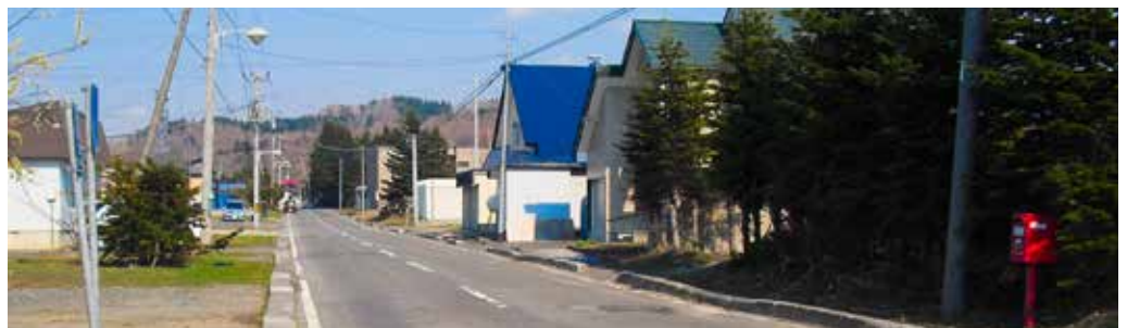
町道北進幌延線
