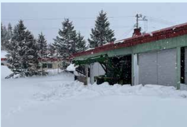
問寒別地区町営草地牧場の除雪風景
