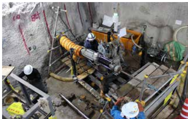
写真 深度250mからのボーリング調査の様子
