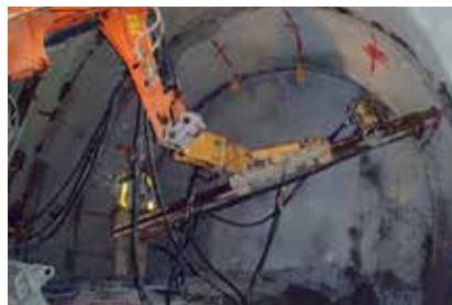
写真6 ロックボルト設置
