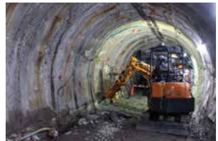
写真1 掘削開始時の様子
