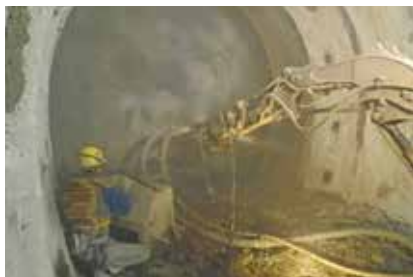
写真5 コンクリート吹付け
