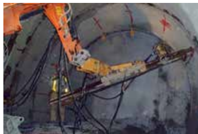
写真6 ロックボルト設置
