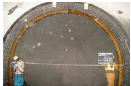
写真4 鋼製支保の設置
