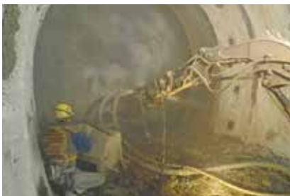
写真5 コンクリート吹付け
