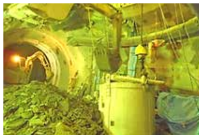
写真3 掘削土（ズリ）出し
