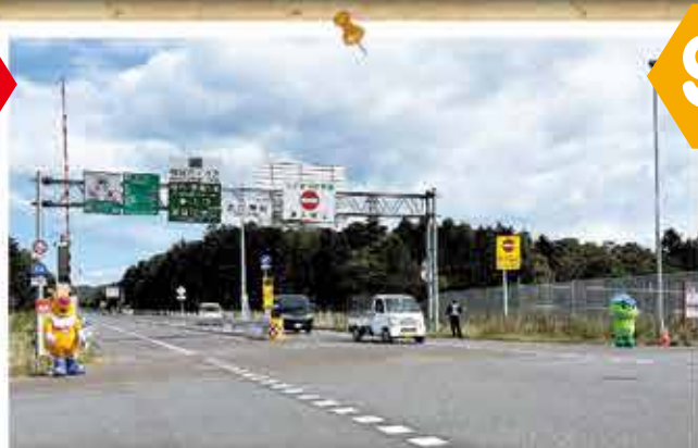
国道 40 号天塩防災開通
