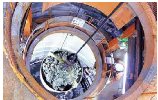
写真 東立坑からの掘削土（ズリ）搬出の様子
