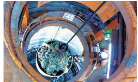
写真2 掘削土（ズリ）の搬出
