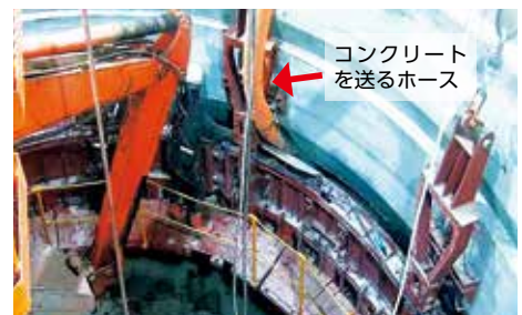
写真4 コンクリート打設
