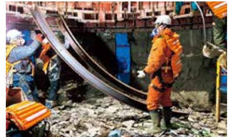
写真3 鋼製支保の設置
