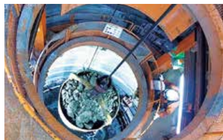
写真2 掘削土（ズリ）の搬出
