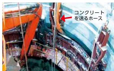
写真4 コンクリート打設
