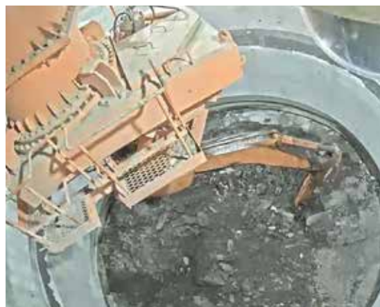
9月5日、東立坑掘削工事深度500m到達
