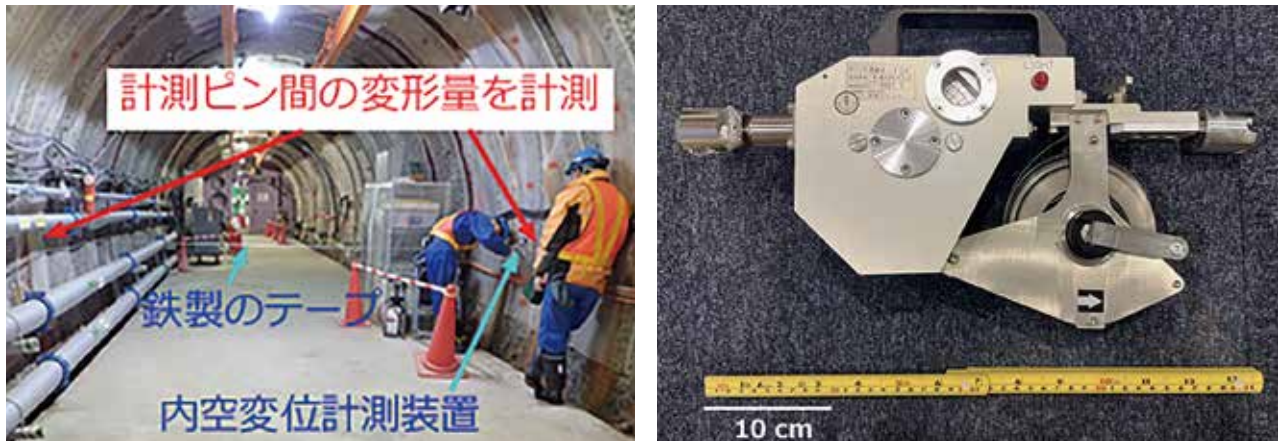
図3 坑道の変形を計測している様子（左）と、内空変位計測装置（右）
