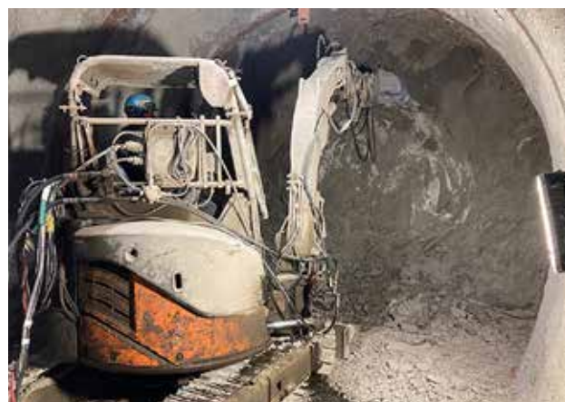
【500m 調査坑道の貫通】
