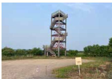
町営草地幌延団地監視塔
