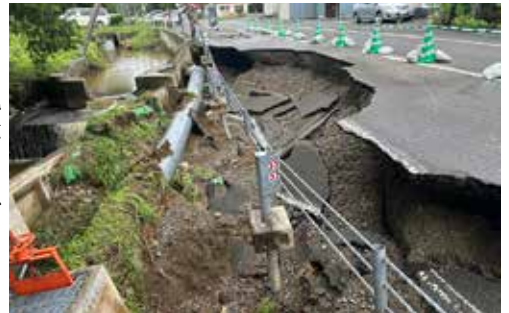
8月の大雨による幌延1号線道路陥没
