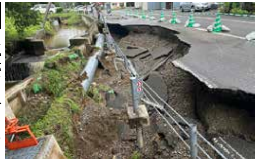
8月の大雨による幌延1号線道路陥没
